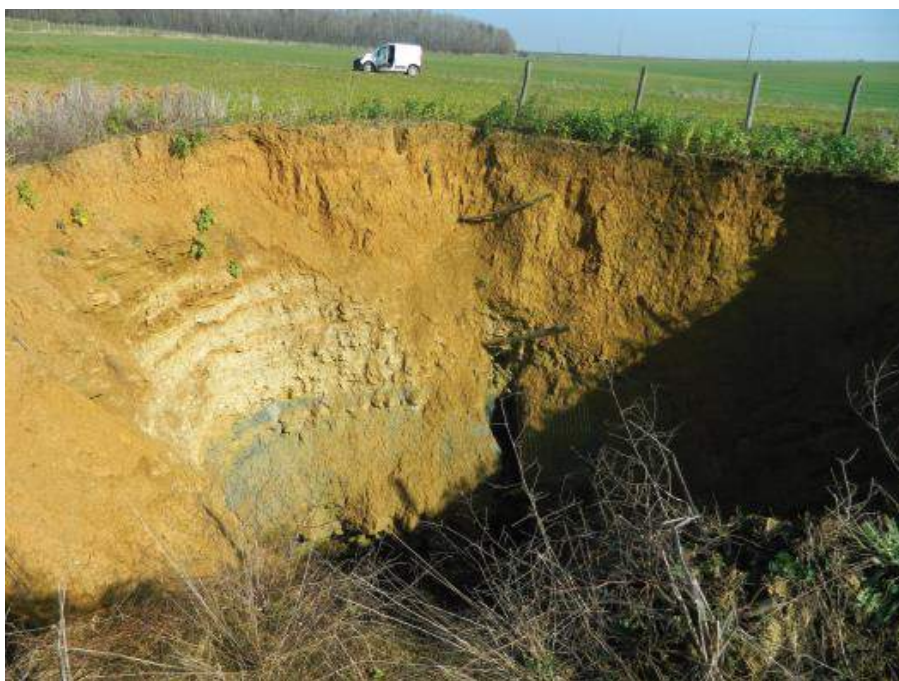
FIGURE 92 EFFONDREMENT DE CAVITE A COURCELLES-SUR-BLAISE SOURCE BRGM ET DDT 52
